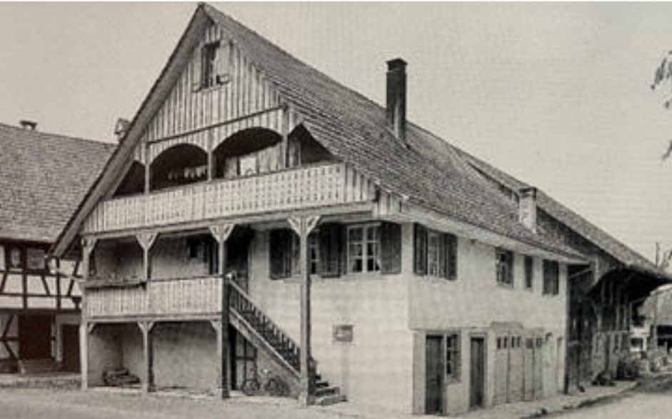
Die offene Aussenerschliessung einer Giebelseitigen Laube
